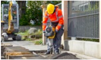
Technique de démolition
